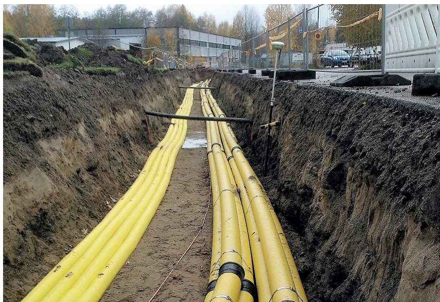
Kuvassa oikeaoppinen 20kV ja 110kV johtojen sijoitus samaan kaivantoon.
